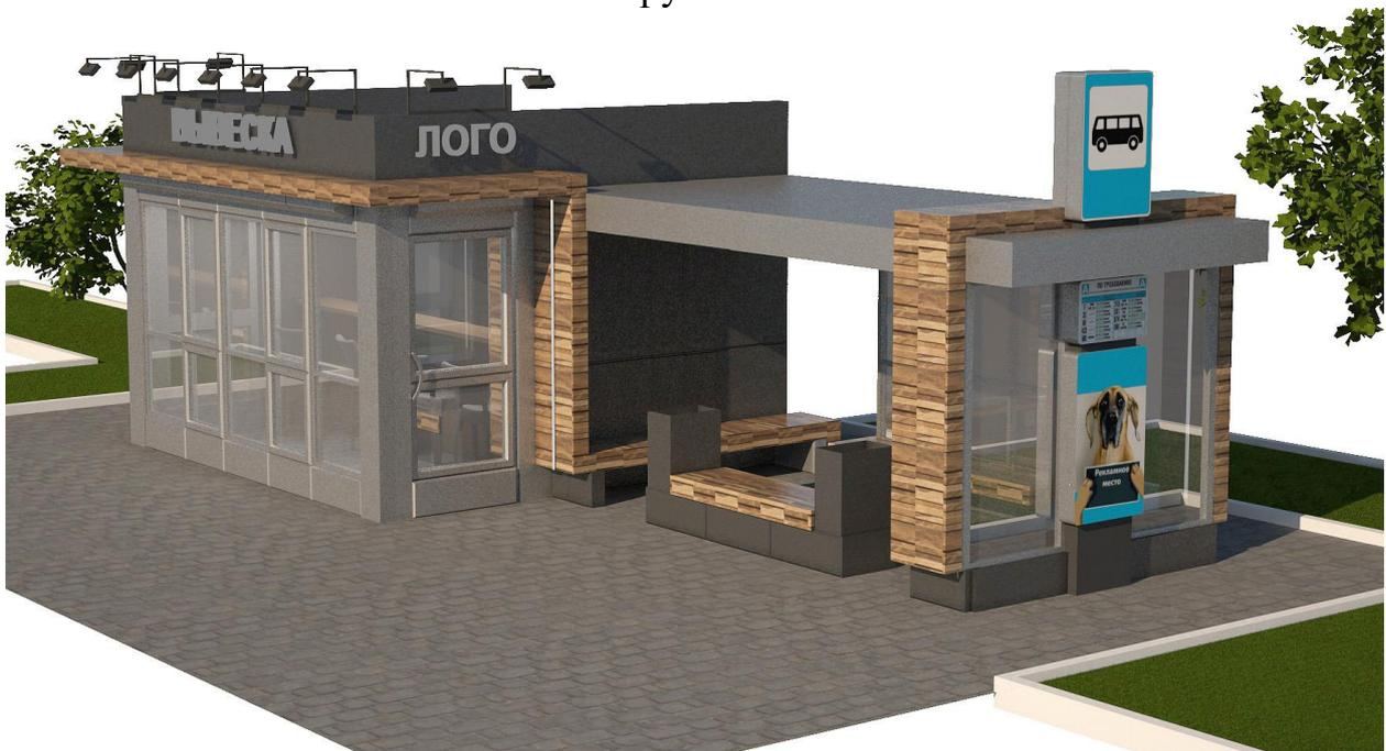
Конструктивная схема НТО, входящего в состав остановочного комплекса, – металлический или иной каркас с заполнением утеплителем. Облицовка наружных стен – металлокассеты. Цвет по цветовому стандарту RAL – оттенки серого (RAL 7004, RAL 7005, RAL 7022). Дверь для служебного входа размещается на одном из торцевых или заднем фасадах, исходя из расположения НТО. Дверь входная для покупателей размещается
