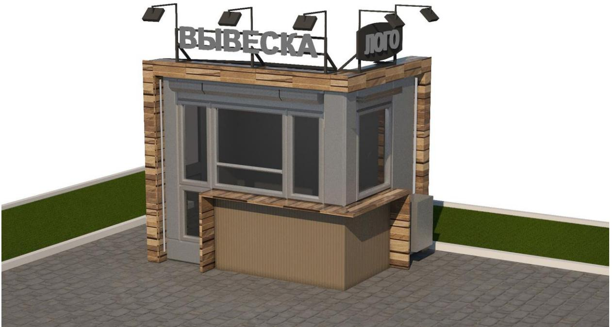
Конструктивная схема – металлический или иной каркас с заполнением утеплителем. Облицовка наружных стен киоска – металлокассеты. Цвет по цветовому стандарту RAL – оттенки серого (RAL 7004, RAL 7005, RAL
